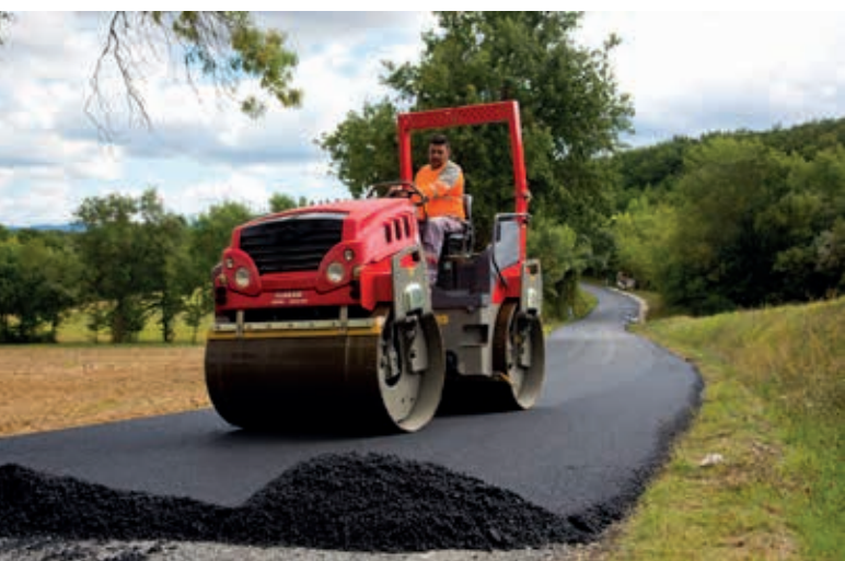
Travaux de voirie à Navès
