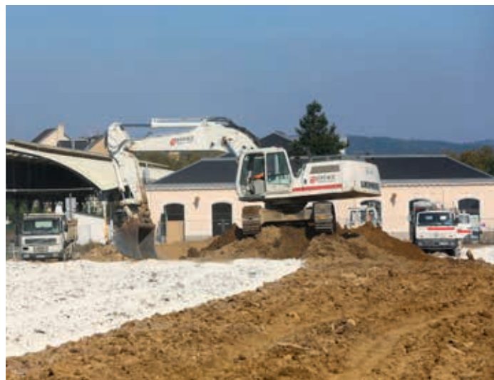
Le chantier du Pôle d'Echanges Multimodal de Castres.
