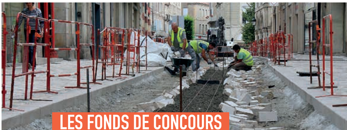
Réaménagement de la rue Sabatier à Castres
