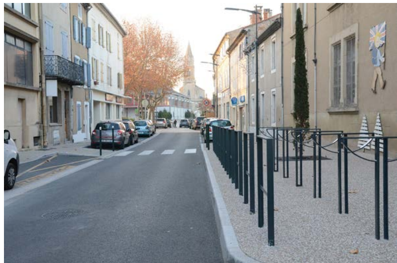
Réaménagement de la rue Mahuziès à Castres.
