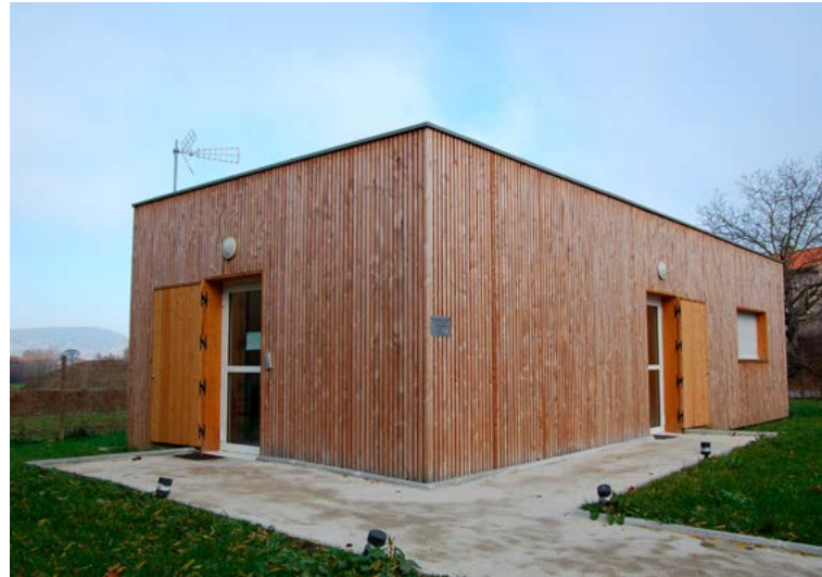
Construction du local médical à Aiguefonde.
