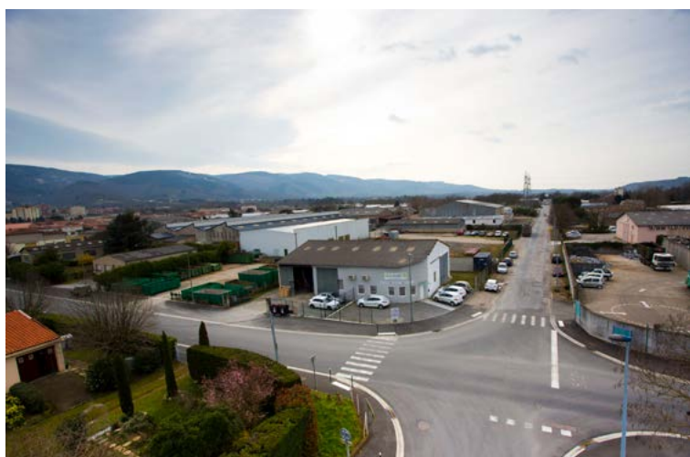
La ZA de la Rougearié en cours de restructuration.
