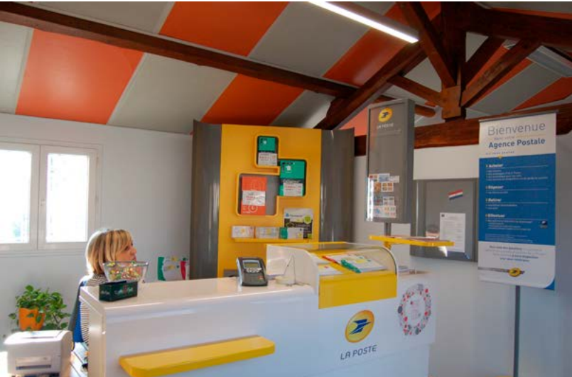
Rénovation de l'agence postale de Noailhac.
