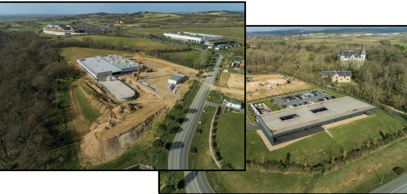
Les chantiers Syselec et IMS Networks.
