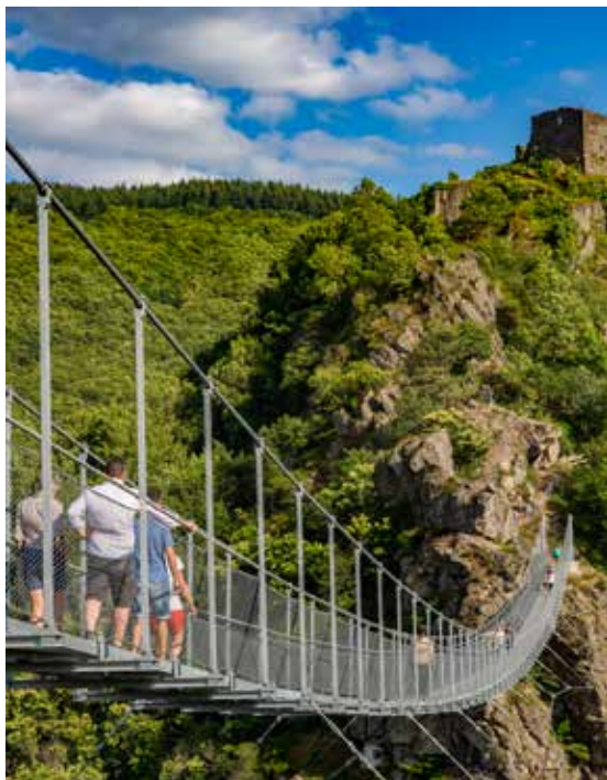
Une passerelle himalayenne permet de traverser les gorges de l'Arnette à Mazamet
