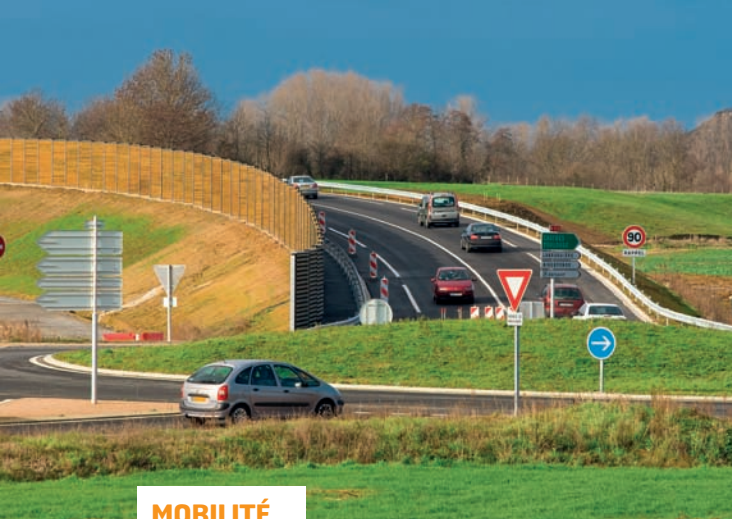
Le contournement de Saint-Alby n'est qu'une première étape dans l'aménagement du tronçon Mazamet / Labruguière.
