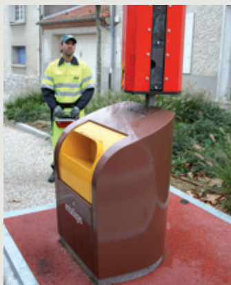
Les conteneurs enterrés sont adaptés pour la collecte en centre-ville. Ils sont peu encombrants, esthétiques, accessibles 24h/24, faciles d'entretien et ils nécessitent peu de passages de camions.
